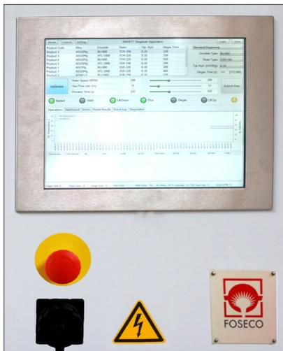
Imagen 3: Interfaz de pantalla táctil en una puerta de armario de control FDU
